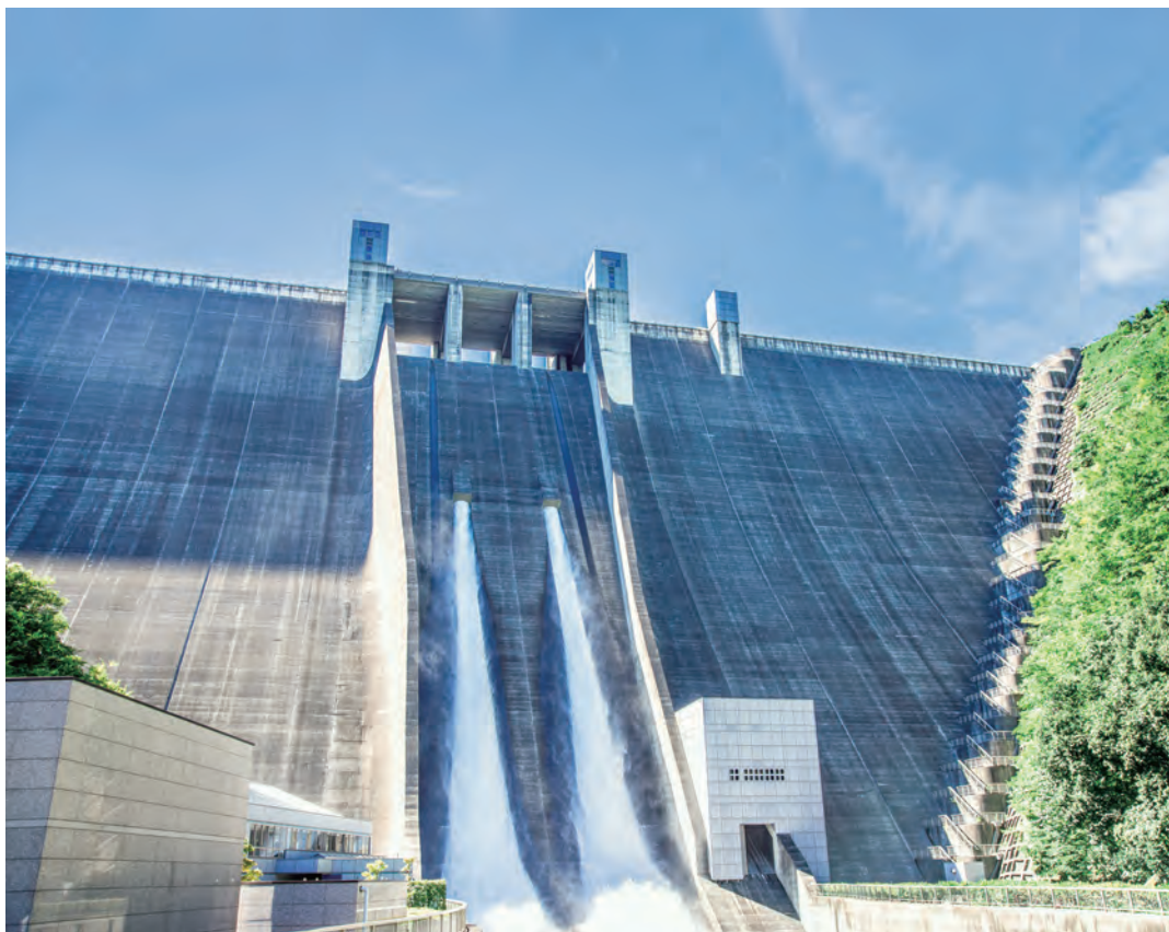
放流中の宮ヶ瀬ダム
